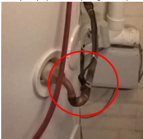
Figure 4 positionnement sonde de température deportée
